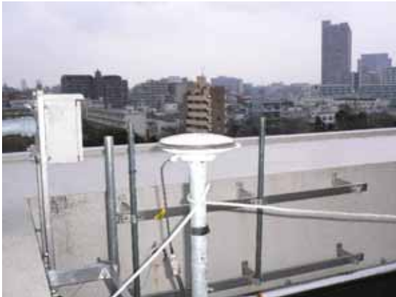
図 4-2 屋上北のアンテナ
