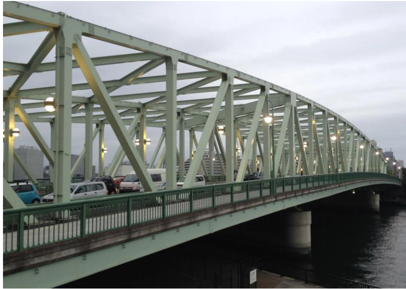
衛星からの信号が遮断される鉄橋
