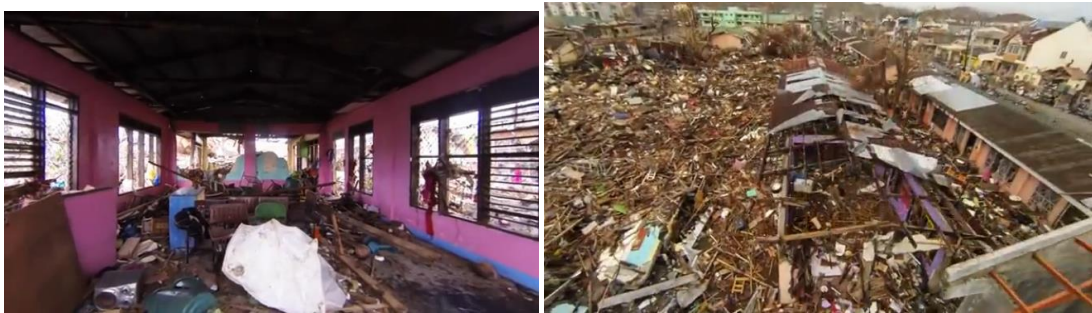
図 3-2 : UAV で撮影された映像で左が屋内、右が屋外
