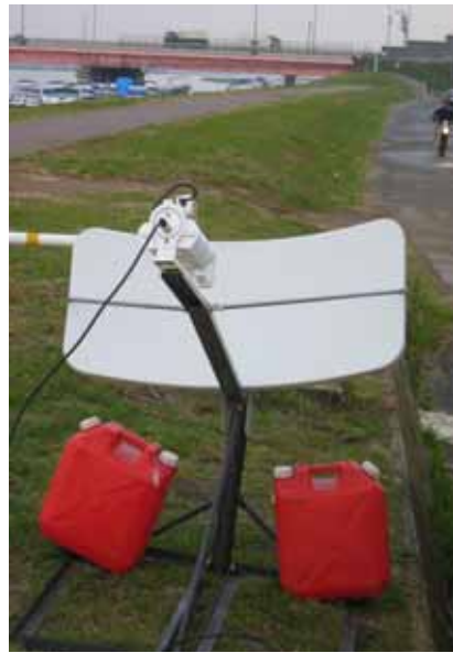
図6 26:VSAT 地球局設置状況
