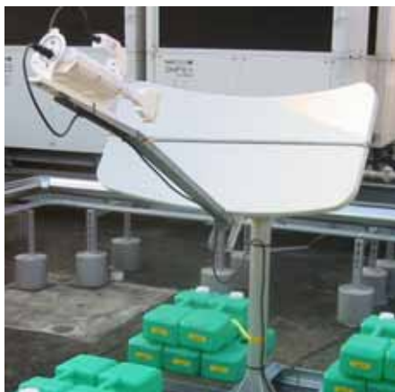
図6-1: パラボラアンテナと ODU
