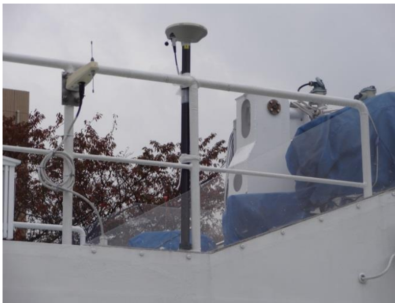
右舷前方に設置したアンテナ
